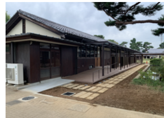
▲旧女子部校舎に外廊下を設置
